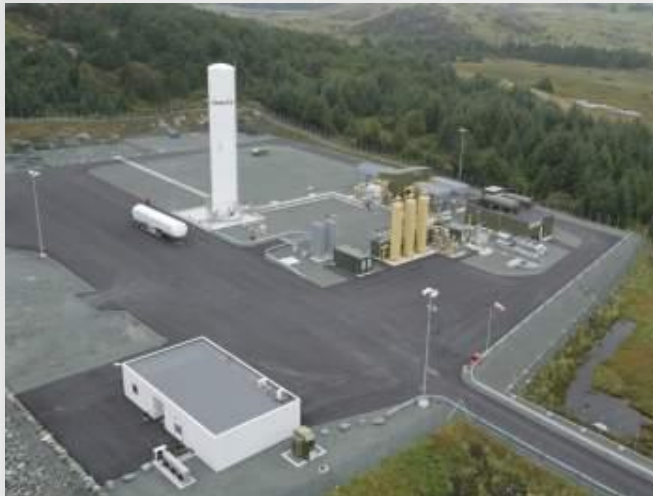
Snurrevarden LNG Plant (22,000 tpy )
