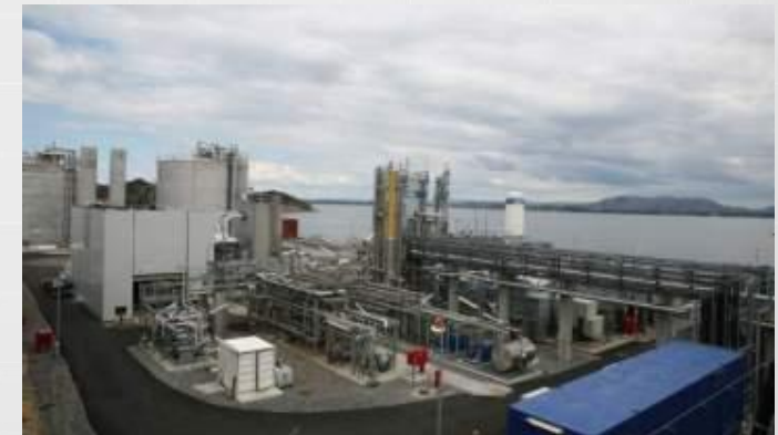
Kollsnes II (Gasnor) LNG Plant (84,000 tpy )
