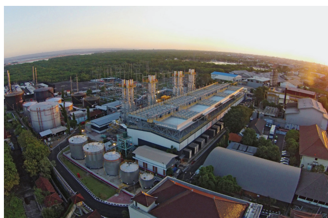
Nhà máy PLTDG Pesanggaran ở Bali, Indonesia với công suất 200 MW sử dụng 12 động cơ engine đa nhiên liệu 50DF của Wärtsilä.
