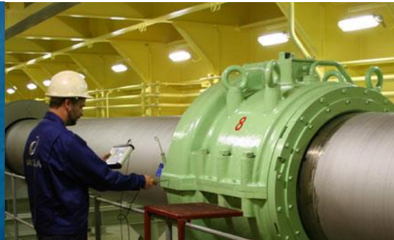
TIIVISTEIDEN JA LAAKEREIDEN HUOLTO
