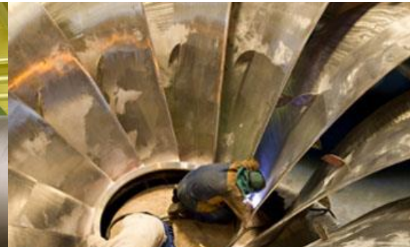
VESIVOIMA- JA TEOLLISUUS- HUOLTO
