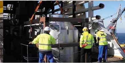
PAKOKAASUJEN PUHDIS- TUSJÄRJESTELMÄT
